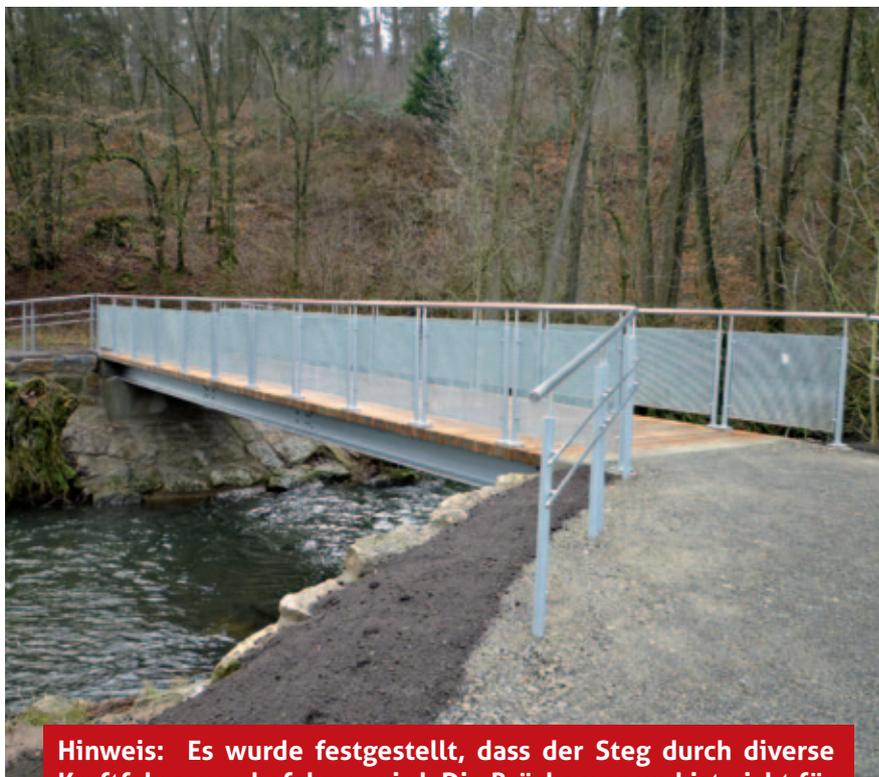
**Hinweis:** Es wurde festgestellt, dass der Steg durch diverse Kraftfahrzeuge befahren wird. Die Brücke war und ist nicht für diese Verkehrslast ausgelegt. Die Benutzung durch Kraftfahrzeuge ist daher nicht gestattet.
