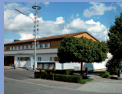
Renovierter Stadtsaal übergeben
