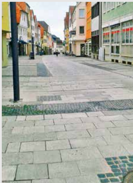
Blick in die Hohnstraße aus Sicht Sparkasse zum Abschluss der Bauarbeiten
