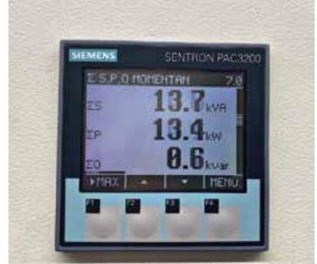
Energiezähler der Maschine
