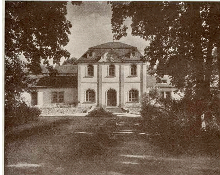
MITTELBAU DES BADEHAUSES
