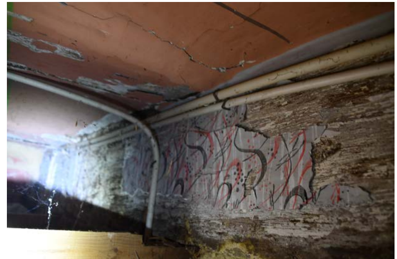
SCHADENSERFASSUNG - BAUTEILÖFFNUNGEN DECKE ÜBER EG
