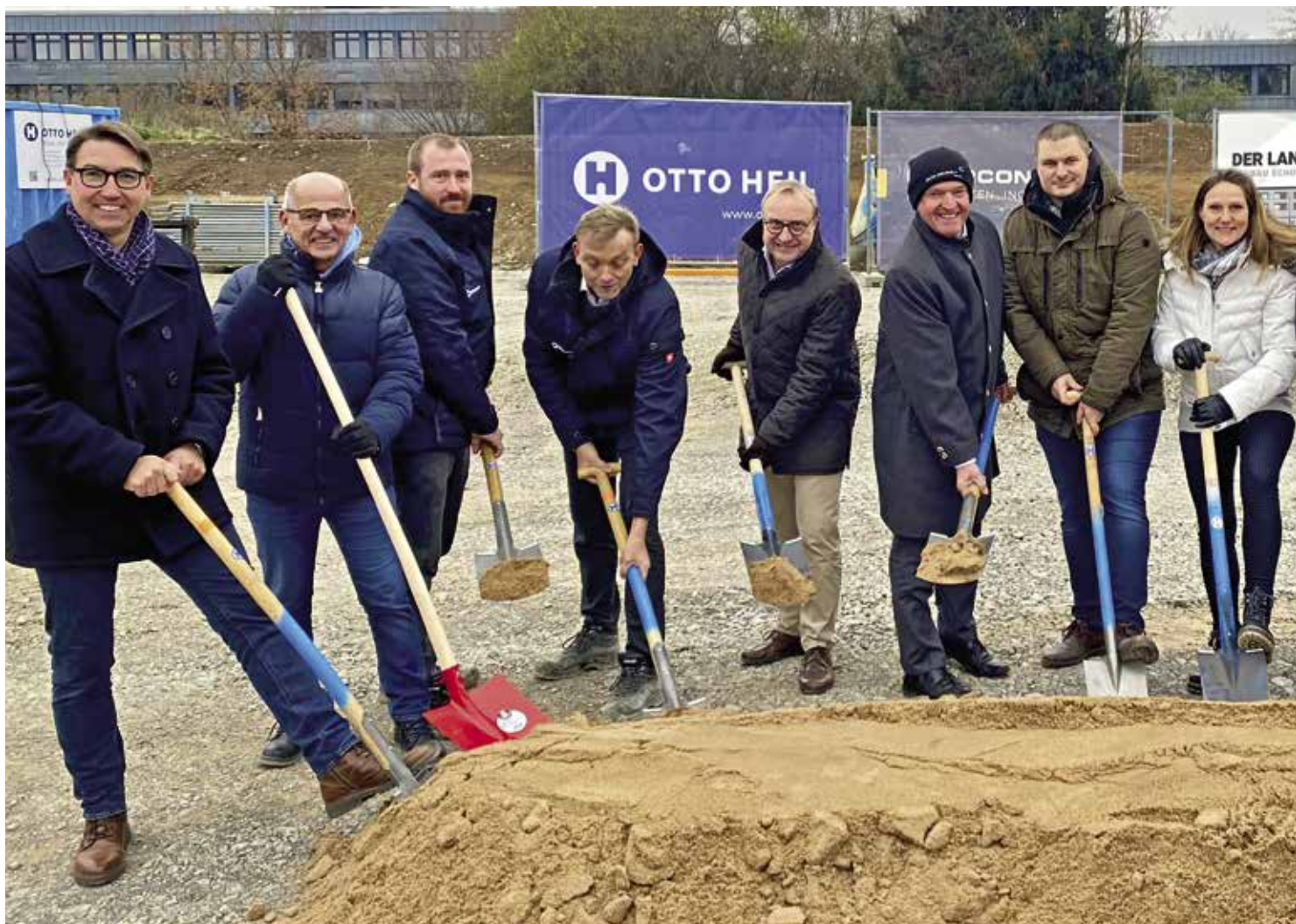
Nach dem feierlichen Spatenstich mit allen (Bau-)Verantwortlichen gehen die Bauarbeiten am neuen Schülerwohnheim der Jakob-Preh-Schule in Bad Neustadt nun offiziell los. Foto: Christian Hüther / Landkreis Rhön-Grabfeld
