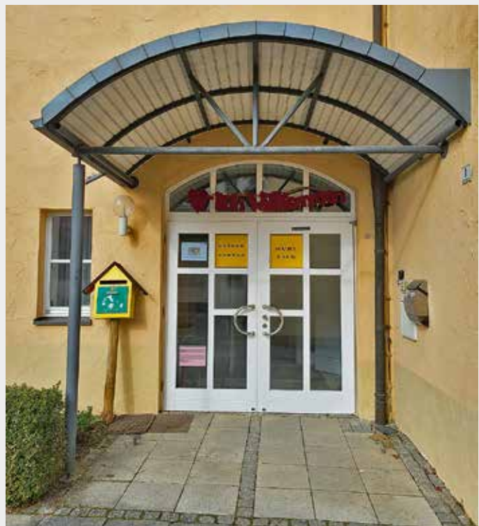
Der Eingang des Pfarrzentrums Mühlbach, das als Ausweichgebäude während der Umbauphase des Kindergartens genutzt wird.
