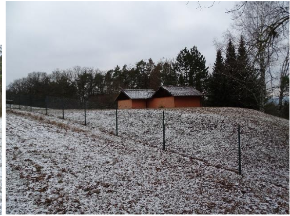
Abb. 4: Hochbehälter nördl. geplanter Bebauung (BAURCONSULT 21.01.2019)
