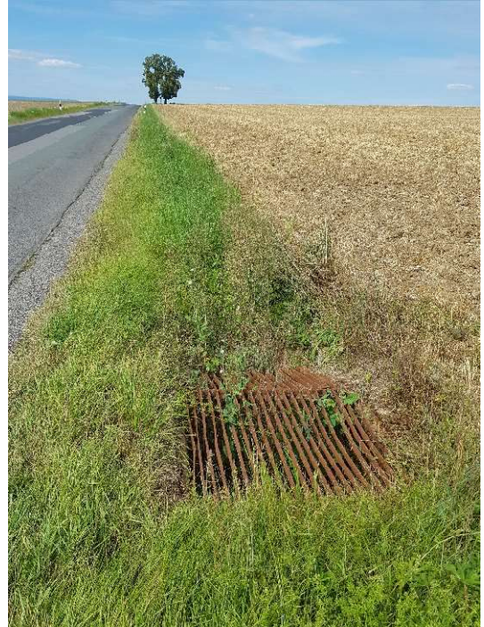
Abb. 7: Blick auf die Baumgruppe mit Baudenkmal nordwestlich des Plangebietes
