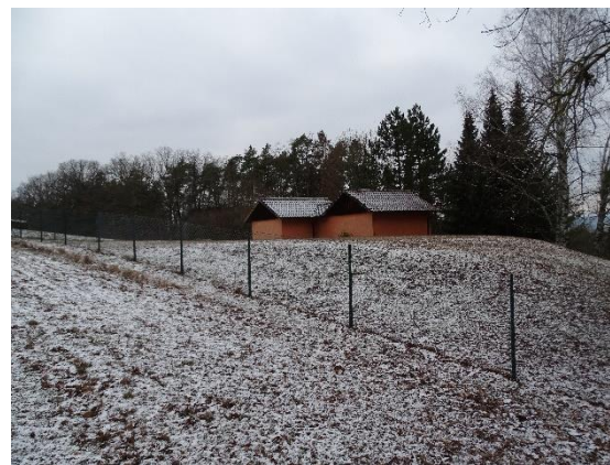
Abb. 5: Hochbehälter nördl. geplanter Bebauung (BAURCONSULT 21.01.2019)
